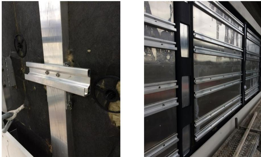
**Abbildung 169: Zwei Arten der Befestigung: 1) auf einem Vierkantrohr (links) oder auf einem Alu-Tafelblech mit Agraffenprofil für maximale Flexibilität im Capaporfeld (rechts).**
