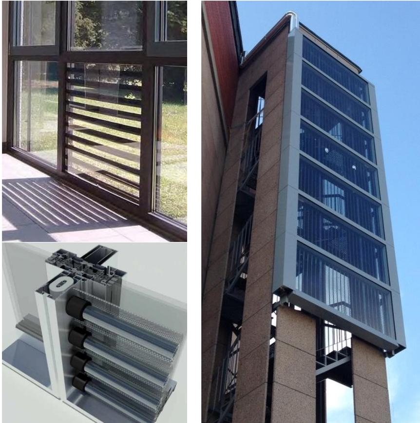
**Abbildung 6: (oben links) Teiltransparenter solarthermischer Kollektor „Solar Thermal Glass“ von Robin Sun, (unten links) Teiltransparenter Fassadenkollektor von Ritter XL Solar, (rechts) TSTC von Permasteelisa.**
