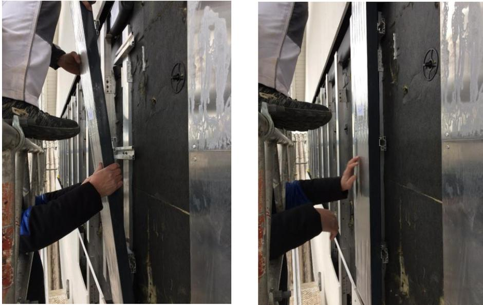
**Abbildung 170: Einfaches Einhängen des Kollektors in die Agraffenhalterungen.**
