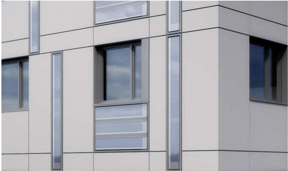
Abbildung 7: Visualisierung vertikale und horizontale Integration des Streifenkollektors in ein VHF-System/ IBK2
