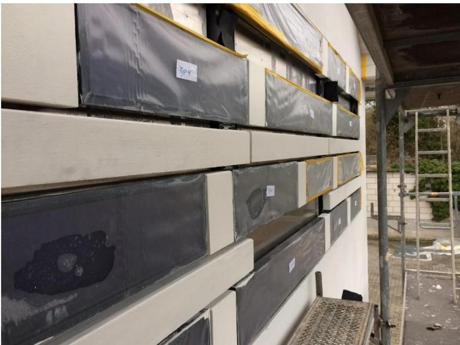
Montierte Dekor- und Solarelemente auf Agraffensystem
