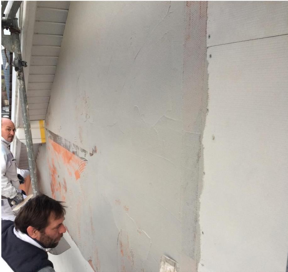
Aufbringen der Armierungsschicht mit Gewebeeinlage auf der Fläche
