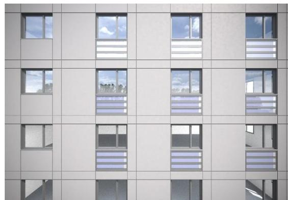
Abbildungen 32 -33: Visualisierung Streifenkollektor in einer Bürofassade/ IBK2
