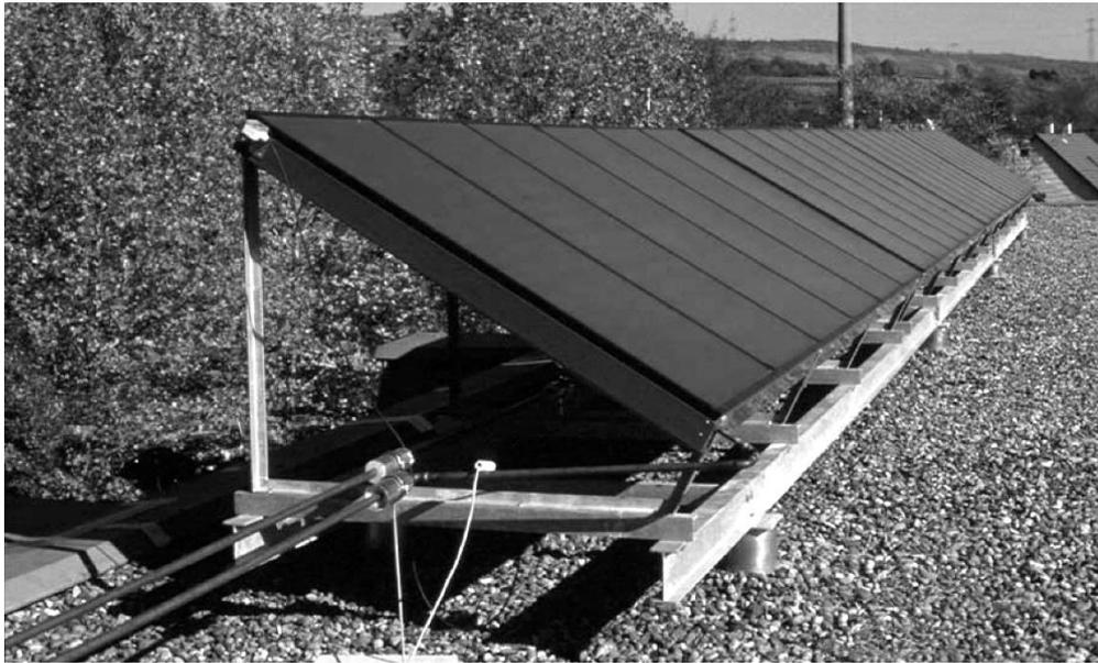
Abbildung 2: Kollektorintegration als Aufdach-Konstruktion/ Solites
