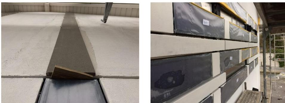
**Abbildung 172: Nahezu fertige Fassade mit Capapor-Designelementen (links: dunkelgrau, rechts: weiß).**
