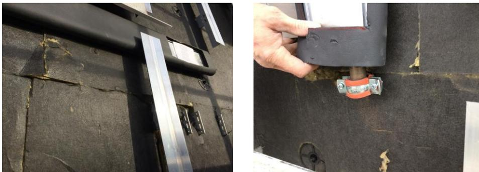
**Abbildung 167: Vorläufige Befestigung der Sammelkanäle.**
