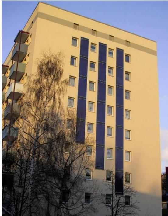
**Abbildung 11: Bild des sanierten Mehrfamilienhauses in Eschwege mit Solarthermie-Elementen an der Fassade.**
