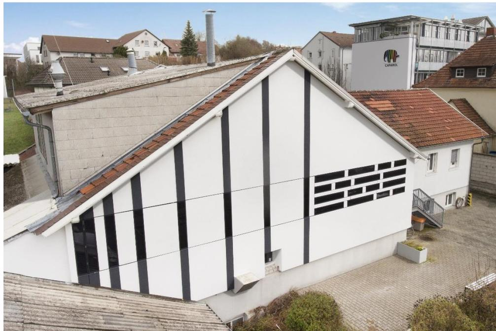
**Abbildung 174: Fertige Demonstratorfassade mit Streifenkollektoren.**
