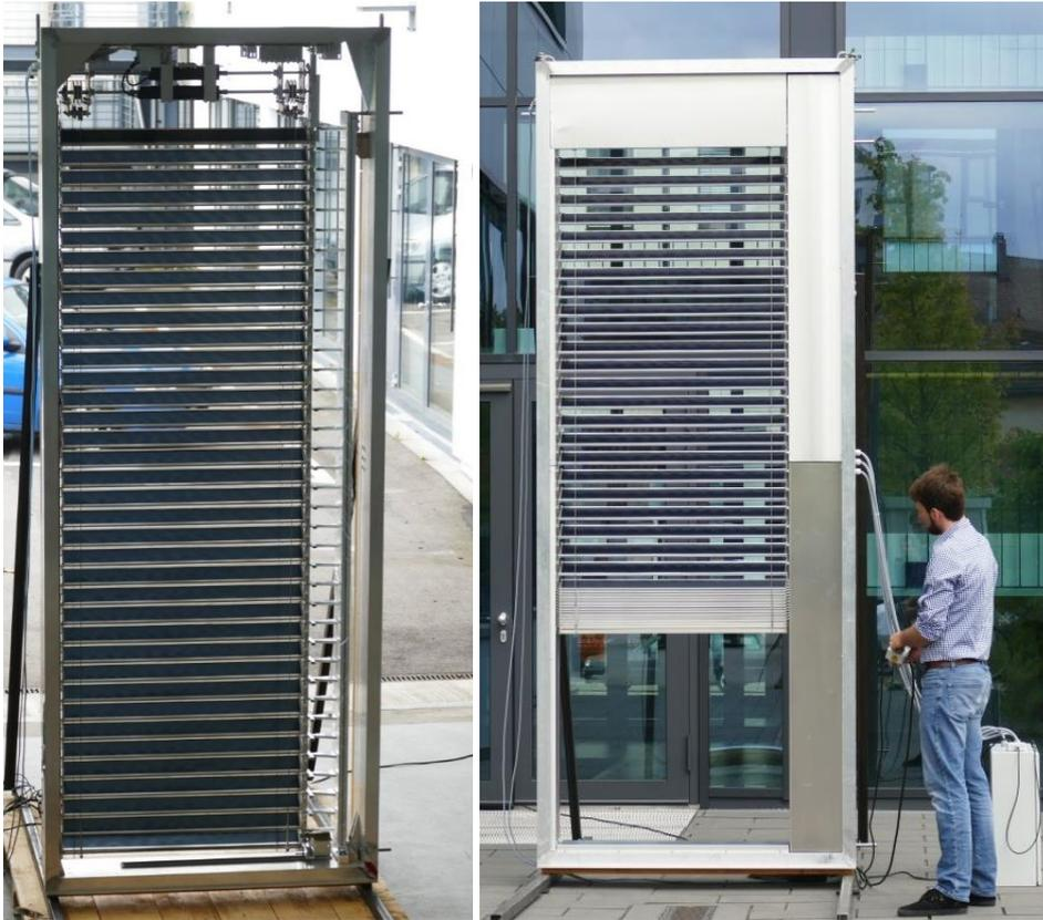
**Abbildung 130: Außenansicht des Fassadenelements. Links: Rahmen des Fassadenelements mit montierter Motorbaugruppe, Lamellen, und Sammelkanal, rechts im Rahmen. Nicht montiert sind Anpressrahmen, Abdeckbleche und Glasscheiben. Rechts: Fassadenelement mit montierten Abdeckblechen, ohne Verglasungen.**
