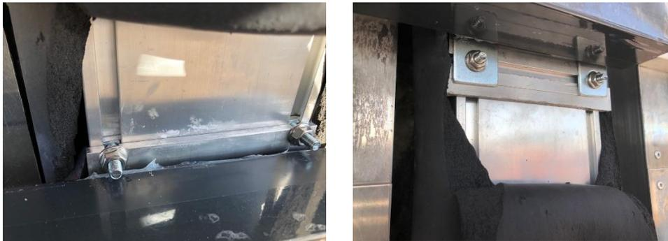
**Abbildung 171: Befestigung der Adapterplatten des Kollektors mit dem Sammelkanal, teilweise mit einer weiteren Adapterplatte (rechts).**
